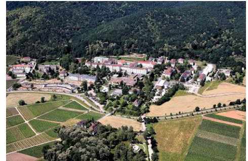
Die anspruchsvolle Ausgangssituation: ein weitläufiger Klinikkomplex.
