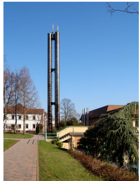
Die ideale Lösung: ein UMTS-Mast direkt auf dem Grundstück.
